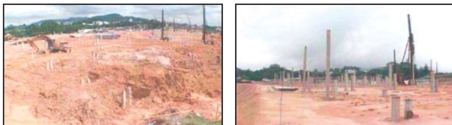
Gambar 3: Kerja-kerja memasang cerucuk sedang dijalankan
