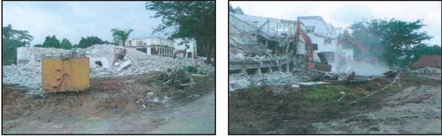
Gambar 5: Kerja-kerja meroboh bangunan lama bekas Hospital Lady Templer
